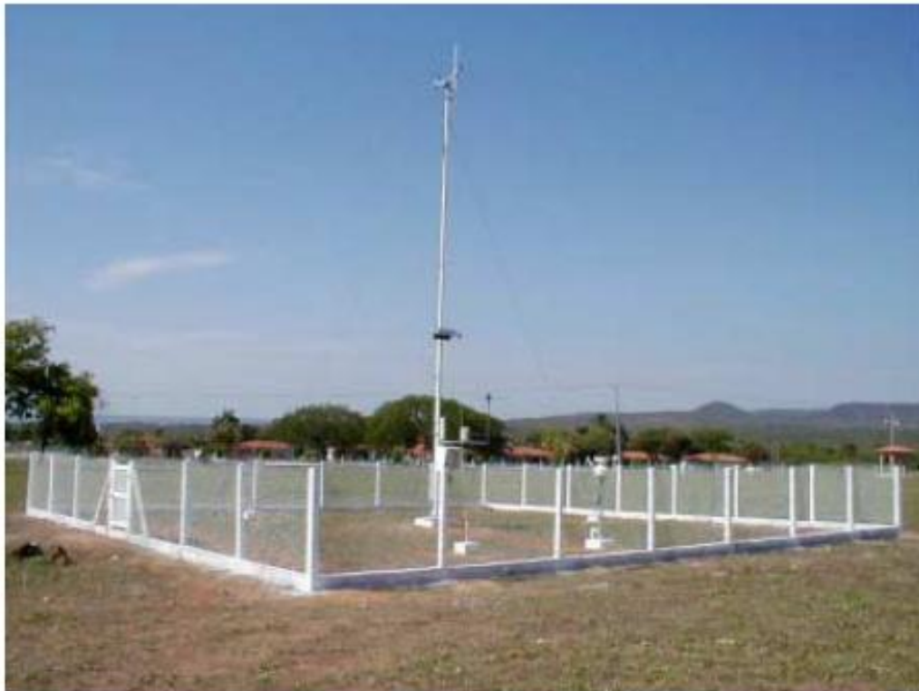
Uma típica Estação Meteorológica Automática – EMA Sensores, mastro com caixa data-logger, painel solar, pára-raios, cercado
